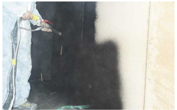
Abb. 4: Resultat: Geschlossene Oberfläche bei pastöser Dickbeschichtung
