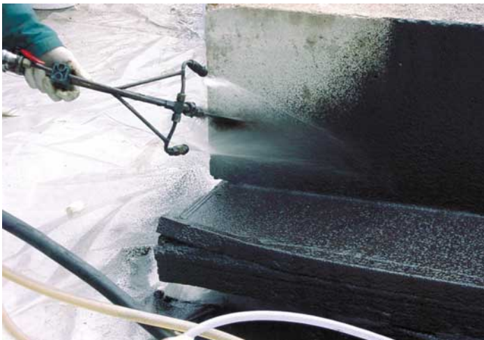
Abb. 5: Sprühstrahlen-Kreuzung: Keine Probleme durch Materialerhärtung durch Mischung außerhalb des Geräts
