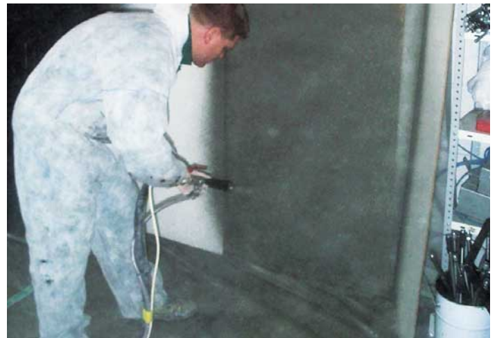
Abb. 6: Beispiel: Einkomponenten-Spritzanlage für mineralische Dichtungsschlämmen
